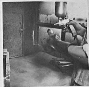
Nüllstellerrahmen werden mit Überzugslack gespritzt spray lacquering of frames
