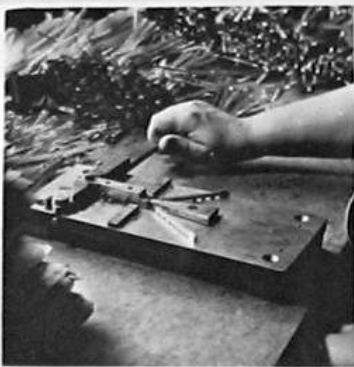
Biegen bzw. Abwinkeln der Zahlenschieber setting of figure-slides (Duplex)
